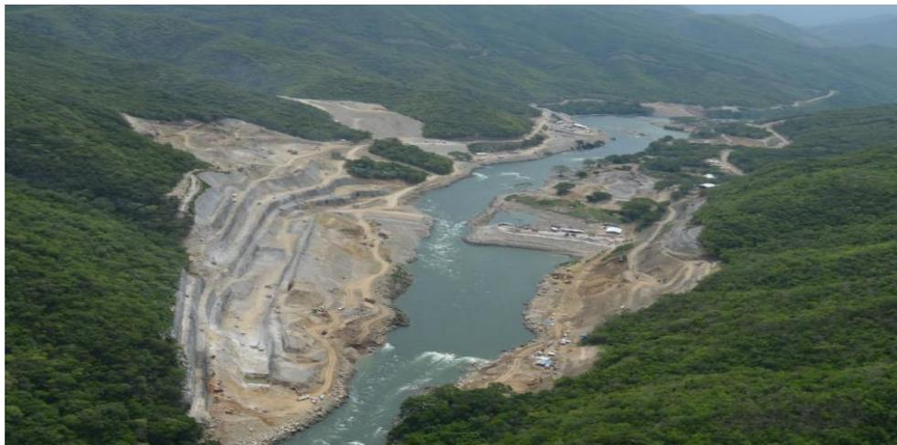
Fotografía: Avance de obra civil en el sitio del PH Chicoasén II, excavación en canal de desvío y ataguía aguas arriba.
