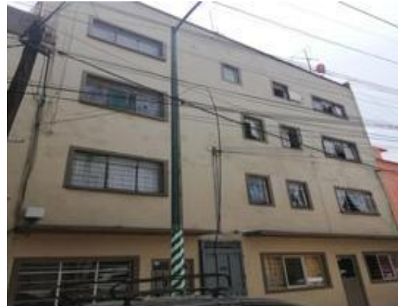
Vivienda Multifamiliar, que podría ser beneficiaria del programa dirigido a casas habitación y multifamiliares.
