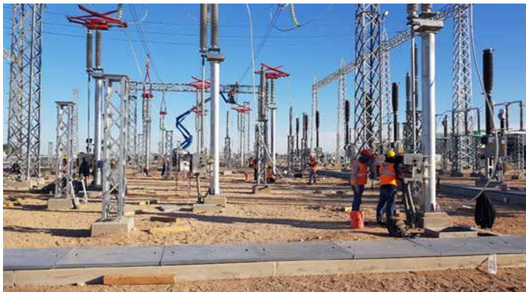
Fotografía: Supervisión técnica de la construcción de la Subestación Mexicali Oriente
