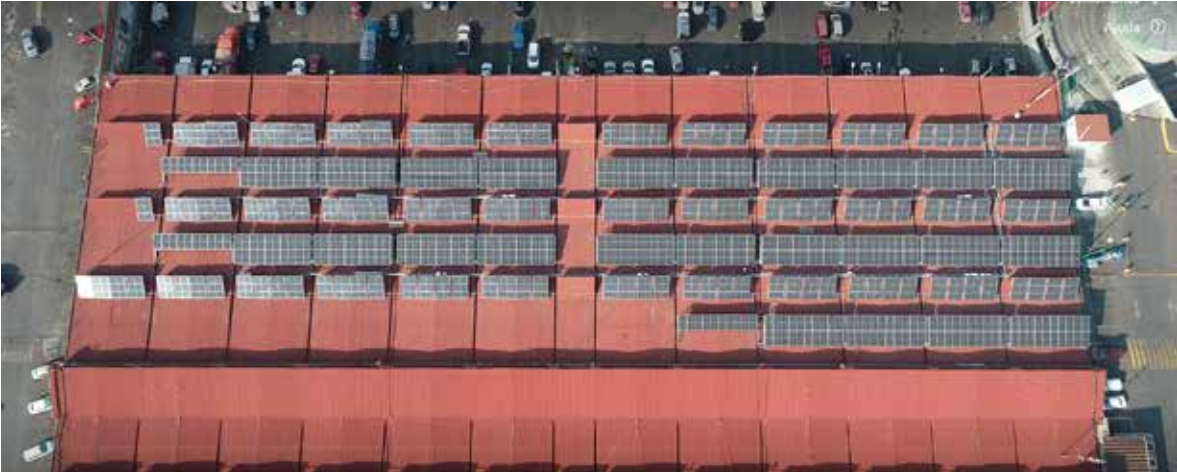
Fotografía: Nave IJ 4-5 del CEDA, instalación concluida de generación distribuida de 500 kW
