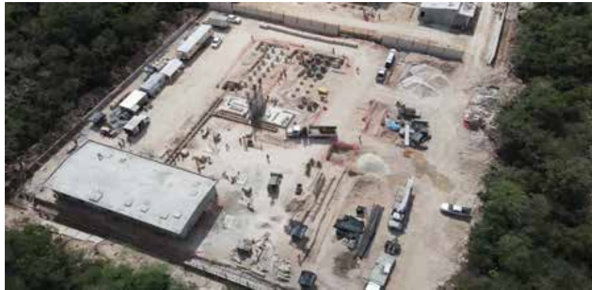
Fotografía: proceso de construcción de la Subestación Tractora 2
